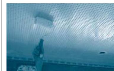
Aplicar sellador al agua con rodillo o pincel a toda la superficie del cielorraso para generar una absorción uniforme a la hora de pintar. Para el uso de selladores seguir indicaciones del fabricante.
