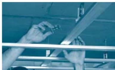
Transversalmente a los perfiles primarios, colocar los perfiles F-47 secundarios, vinculándolos por medio del Caballete Knauf. La distancia entre los F-47 dependerá de la placa a utilizar, siendo 33 cm para la 8/18R y 30 cm para la Slotline B4.
