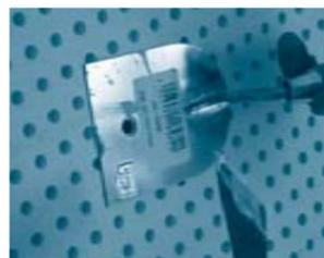
Masillar las cabezas de los tornillos con Uniflott. Recomendación: para evitar ensuciar con masilla las perforaciones, realizar una perforación de diámetro 10 mm en una llana metálica y utilizarla como molde de masillado.
