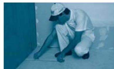
Marcar en el piso y en el techo con hilo entizado, la línea de ubicación de las soleras U 25x20. Separar dicha línea de la pared, mínimamente 60mm, espacio necesario para un buen rendimiento acústico de la placa Cleaneo Akustik.
