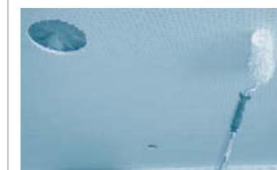
Pintar con rodillo o pincel. No utilizar aerosoles o sopletes debido a que se endurece el velo de fibra y la placa pierde sus propiedades acústicas.
