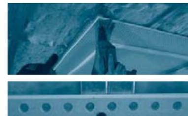
Las placas son fijadas en el cielorraso por medio de tornillos autoperforantes, transversalmente a los perfiles secundarios. Éstas deben estar fijadas cada 170 mm entre ejes.
