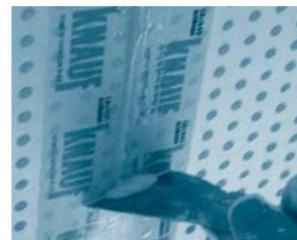
Aplicar una primera capa de masilla con espátula de forma perpendicular a la junta, generando una presión suficiente para que la masilla penetre en toda la profundidad en la junta y evitando que caiga. Aplicar una segunda capa (y tercera si fuera necesario) en el sentido de la junta, con una espátula delgada para que la masilla, una vez seca, quede a nivel de la placa.
