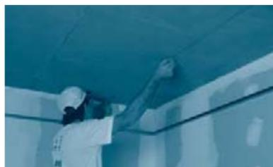
Con ayuda de un metro, medir la posición en la losa de los ejes de los F-47 para luego marcarlos con un hilo entizado o chocla.
