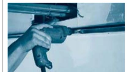
Fijar el perfil U25x20 Knauf a la pared, distanciando las fijaciones cada 600 mm como máximo. **Importante:** Utilizar fijaciones apropiadas para cada tipo de sustrato (hormigón, metal, madera, etc.). Podrán ser clavos de acero o tarugos con tornillos de diámetro mínimo de 8 mm (se recomiendan los tarugos de nylon).
