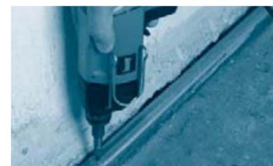
Fijar el perfil U 25x20 Knauf al piso y techo en la misma vertical, distanciando las fijaciones cada 1000mm como máximo.
