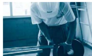
Previo a la fijación del perfil U 25x20 inferior y superior, colocar Banda Acústica Knauf en la cara que va a estar en contacto con piso y techo (alma del perfil).
