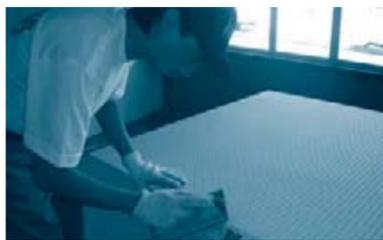
Para la placa Circular 8/18R, los cuatro bordes deben ser lijados con una lija de papel para generar un bisel y de esa forma mejorar el agarre de la masilla Uniflott Knauf.
