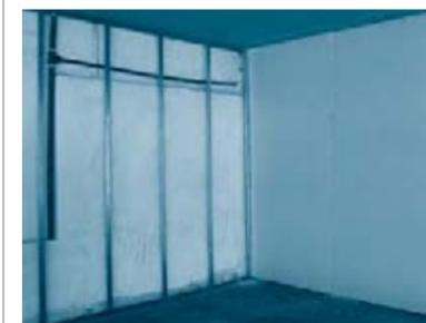
Insertar todos los perfiles F-47 verticalmente, en los U 25x20 superior e inferior, ubicándolos en las marcas previstas según modelo de placa. (Ver: 5. Modulación)
