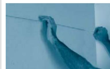
Con un hilo entizado marcar una línea horizontal a la altura de 1.50 m del piso, para la instalación posterior de los mismos.
