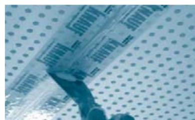
Aplicar una primera capa de masilla con espátula de forma perpendicular a la junta, generando una presión suficiente para que la masilla penetre en la junta y evitando que caiga. Aplicar una segunda capa (y tercera si fuera necesario) en el sentido de la junta, con una espátula delgada para que la masilla, una vez seca, quede a nivel de la placa.
