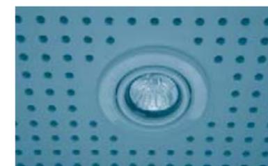
Según el diámetro de la luminaria, perforar suavemente con una mecha copa, previendo anteriormente de no coincidir con la estructura. Luego enmascarar las perforaciones aledañas y masillar.
