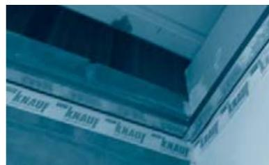
En los lugares donde se produce el encuentro entre la placa de yeso y la construcción tradicional (obra húmeda), o en obras con especificaciones especiales, se realizan distintos encuentros con perfiles Ángulo de ajuste o Buña Z, los cuales se pegan a la placa con cemento de contacto y se terminan con masilla.
