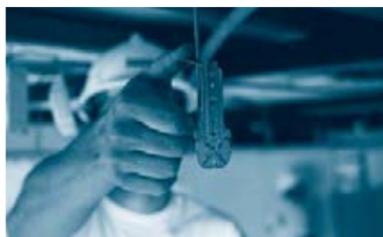
Fijar los cuelgues a la losa con fijaciones de mínimo 8 mm, con una separación máxima de 900 mm.
