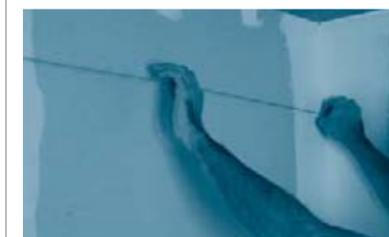
Marcar la altura del perfil U 25x20 Knauf con la ayuda de un nivel láser o de manguera, en las paredes del local donde será instalado el cielorraso. Con el auxilio de un hilo entizado (chocla), marcar la posición exacta donde será fijado el perfil U 25x20 Knauf.
