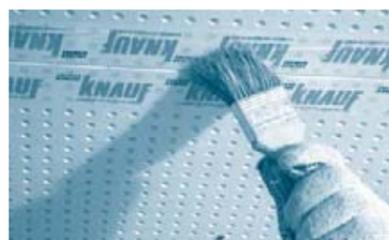
Antes de comenzar el tratamiento de juntas, limpiar todo excedente de polvo con una brocha seca. Posteriormente, dar una imprimación con sellador/fijador al agua con una brocha o pincel delgado, inmediatamente antes del masillado, para que el yeso no absorba el agua de la masilla.
