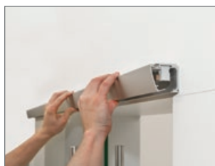
5. Pinzado del perfil embellecedor
