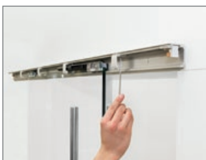
4. Montaje del soporte del embellecedor con la misma llave Allen
