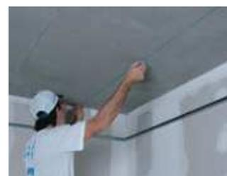
**Marcado de la posición del eje de los F-47**
