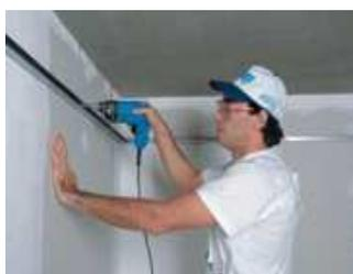
**Fijación de los perfiles perimetrales a la pared**
