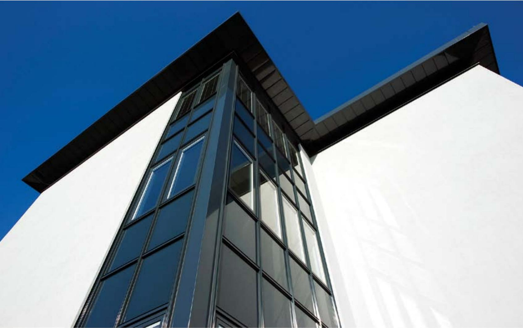
Una construcción con fachada de hoja doble instalada entre forjados es la solución estándar y se realiza de forma rápida y sencilla.
