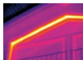
La imagen de infrarrojos identifica las zonas de flujo de calor elevado. Esto lleva a temperaturas superficiales externas más elevadas. Esta termografía de infrarrojos muestra los fallos en la capa de aislamiento de una fachada.
