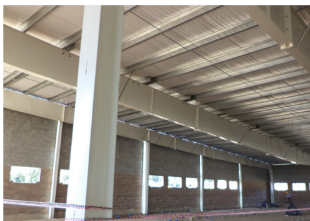
Utilización del Fieltro Tensado en cubiertas nuevas.
