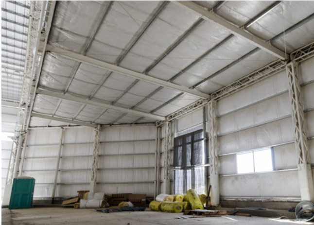
Utilización del Fieltro Tensado Polipropileno Blanco en cubierta y cerramiento vertical.
