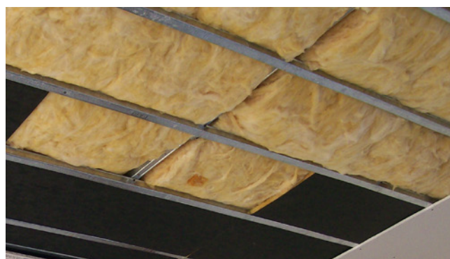
Aislamiento por el interior sobre cielorraso.
