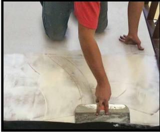
3- Inmediatamente coloque el geotextil y extiéndalo sin dejar traslajos ni pliegues sobre la superficie y con la misma plancha lisa presione hacia abajo.
